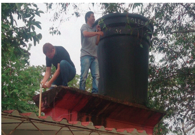
Figura 7. Instalación de la tubería en el tanque principal
