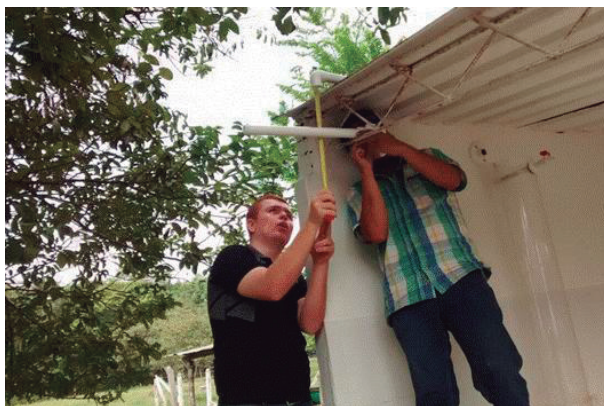
Figura 6. Medición y corte de la tubería para la adecuación de las instalaciones
